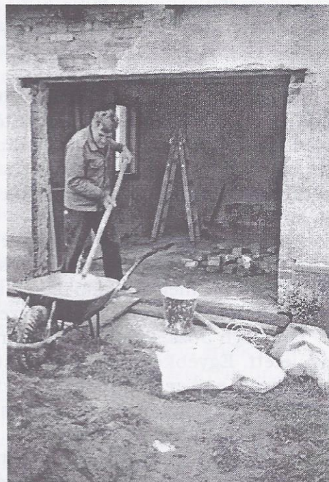
A fajátékkészítő műhely kialakulásáig még sok a teendő. Új kémény, ajtó, ablak, mennyezet, padlózat készítése, illetve átalakítása, hőszigetelése folyik
