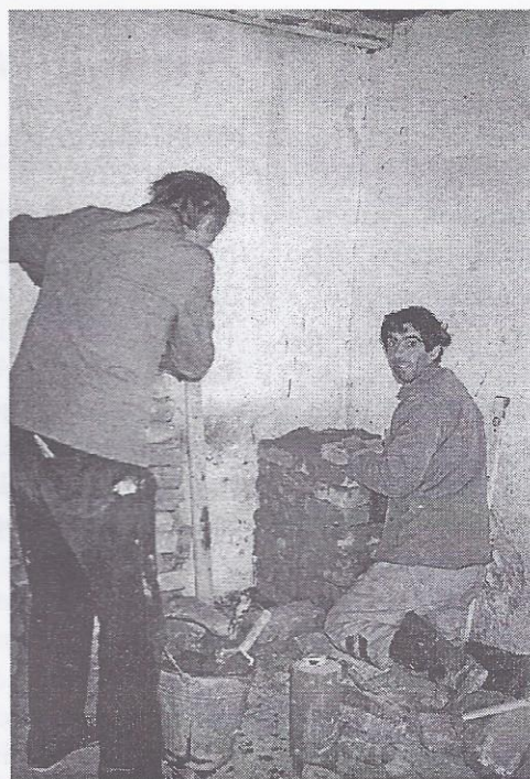
Épül, készül az új fajátékkészítő műhely. A lakóházban már nem fért el, no meg a hely kell a leendő kantinnak. A képen kéménykészítés látható, hiszen télen csak fűtött helyiségben lehet dolgozni.
